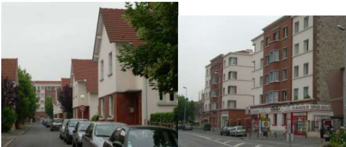
Pavillons de la cité jardin en cœur d'îlot Immeubles collectifs de la cité-jardin
