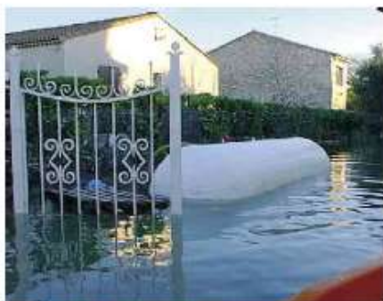
Cuve soulevée par l'eau.
