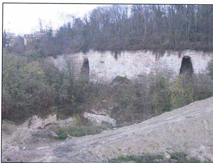
Figure 4 : Cliché des entrées en cavage de la 2 e masse
