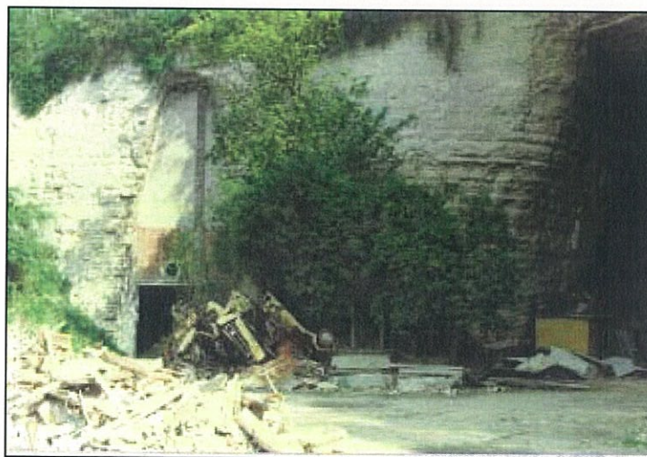
Figure 5 : Cliché des entrées en cavage de la 1 e masse
