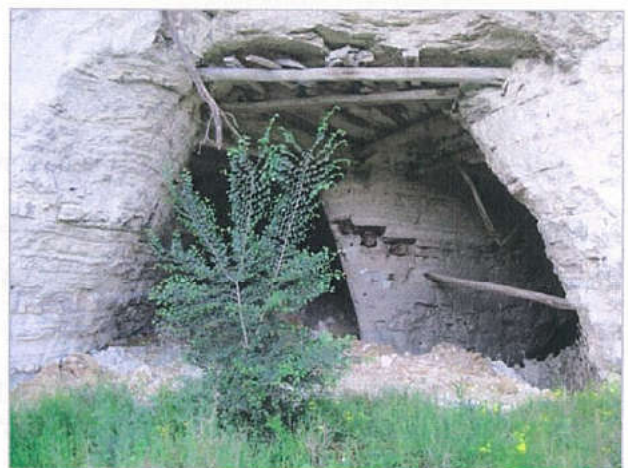
Entrée d'une des galeries © O. Labbaye O.G.E.
