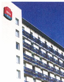
Garde corps solaire
