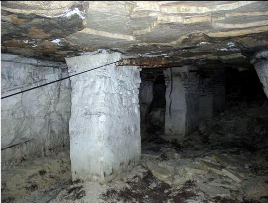
Etat du sous-sol en 2 ème masse
