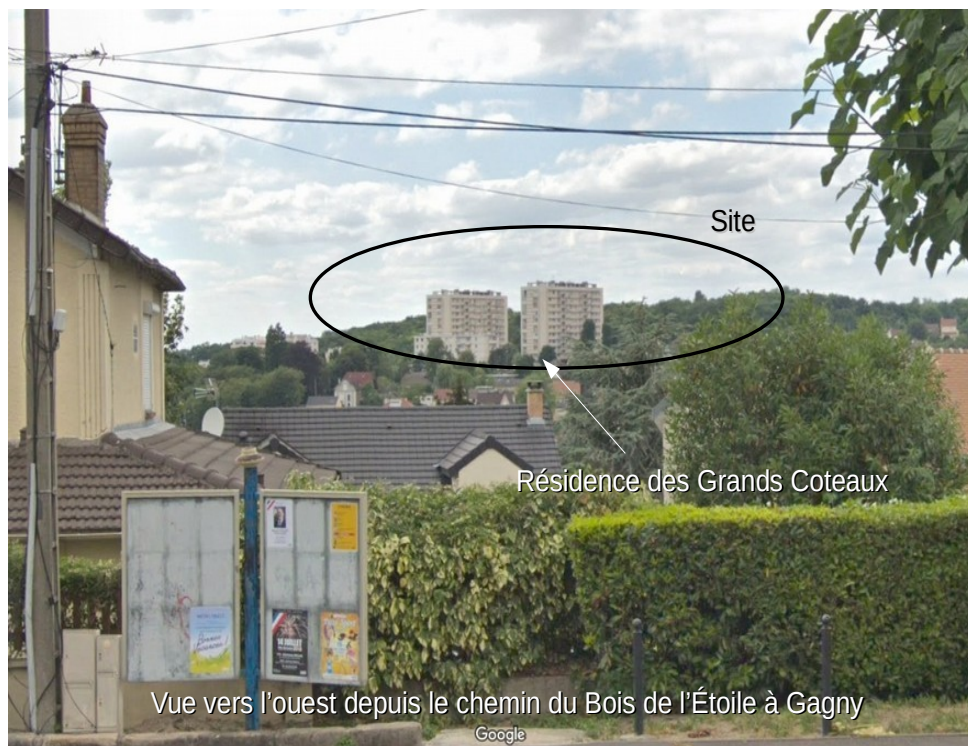
Illustration 7: Vue sur le site depuis le parc du Bois de l'Etoile (source : Google Streetview) – NB : la Résidence des Grands Coteaux est à proximité du site.
